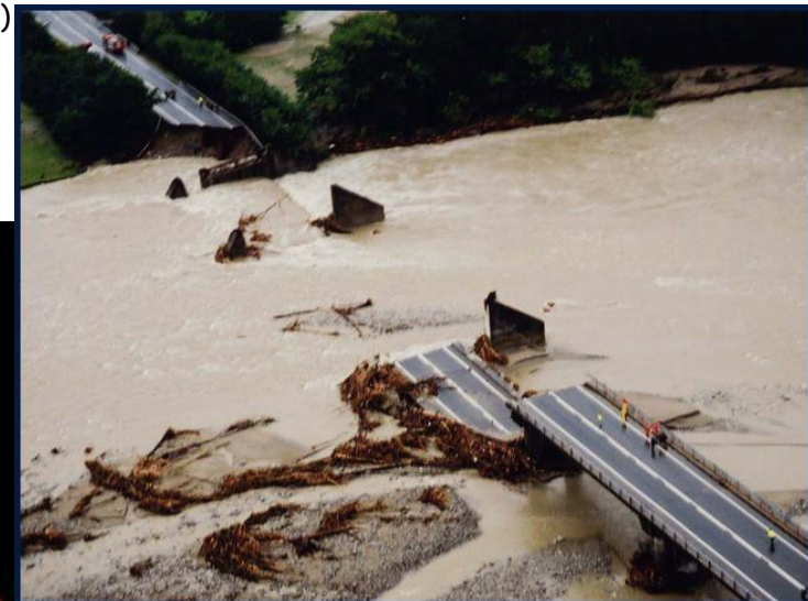
Pedemontana, attraversamento torrente Orco.
